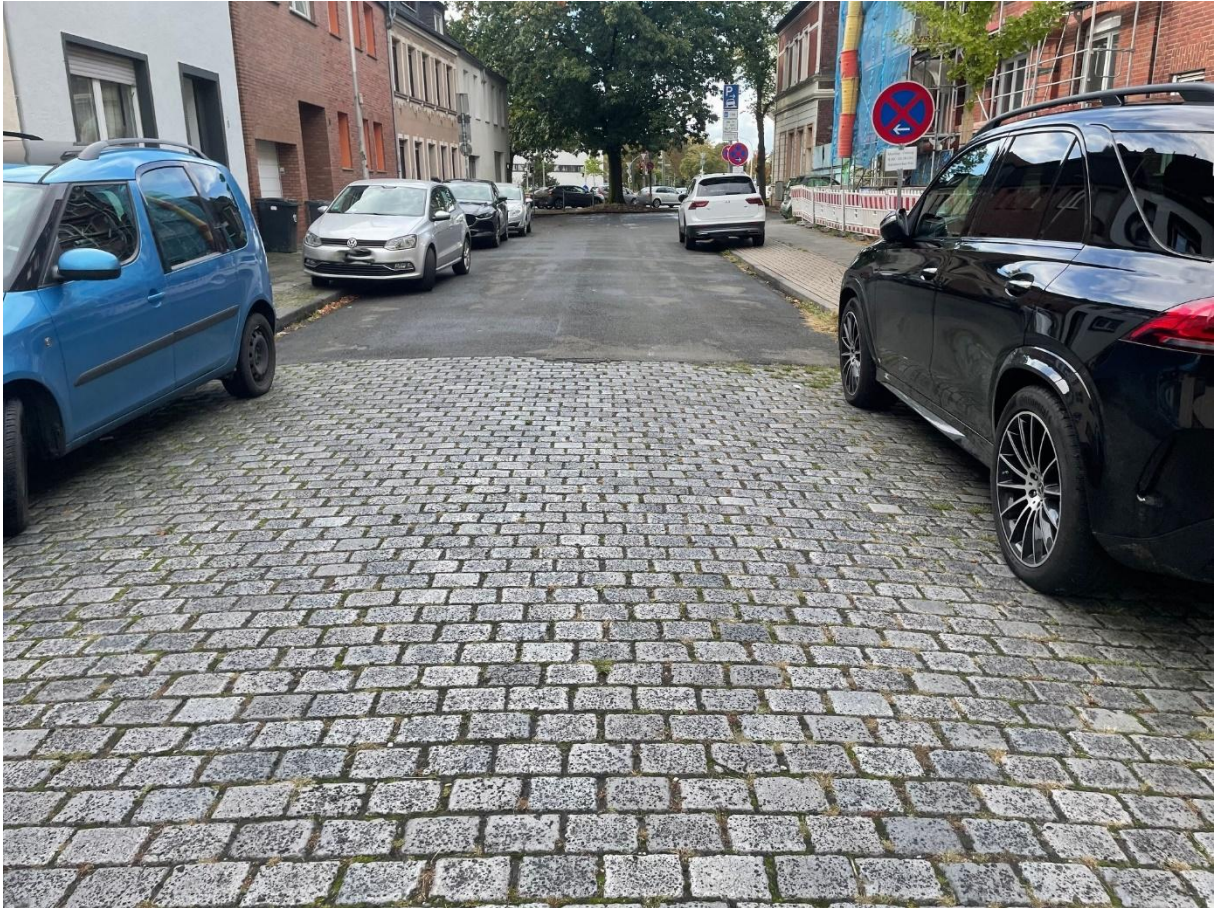
Kentroper Weg mit Blick in den Wendehammer Richtung Westen an der Kreuzung Heßlerstrasse/Ostenallee, Beginn der Schlackestein-Pflasterung bei Hausnummern 3/10
