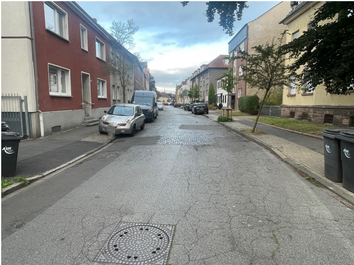
Ende der Schlackesteinpflasterung Höhe Hausnummern 41/42, Blickrichtung Westen
