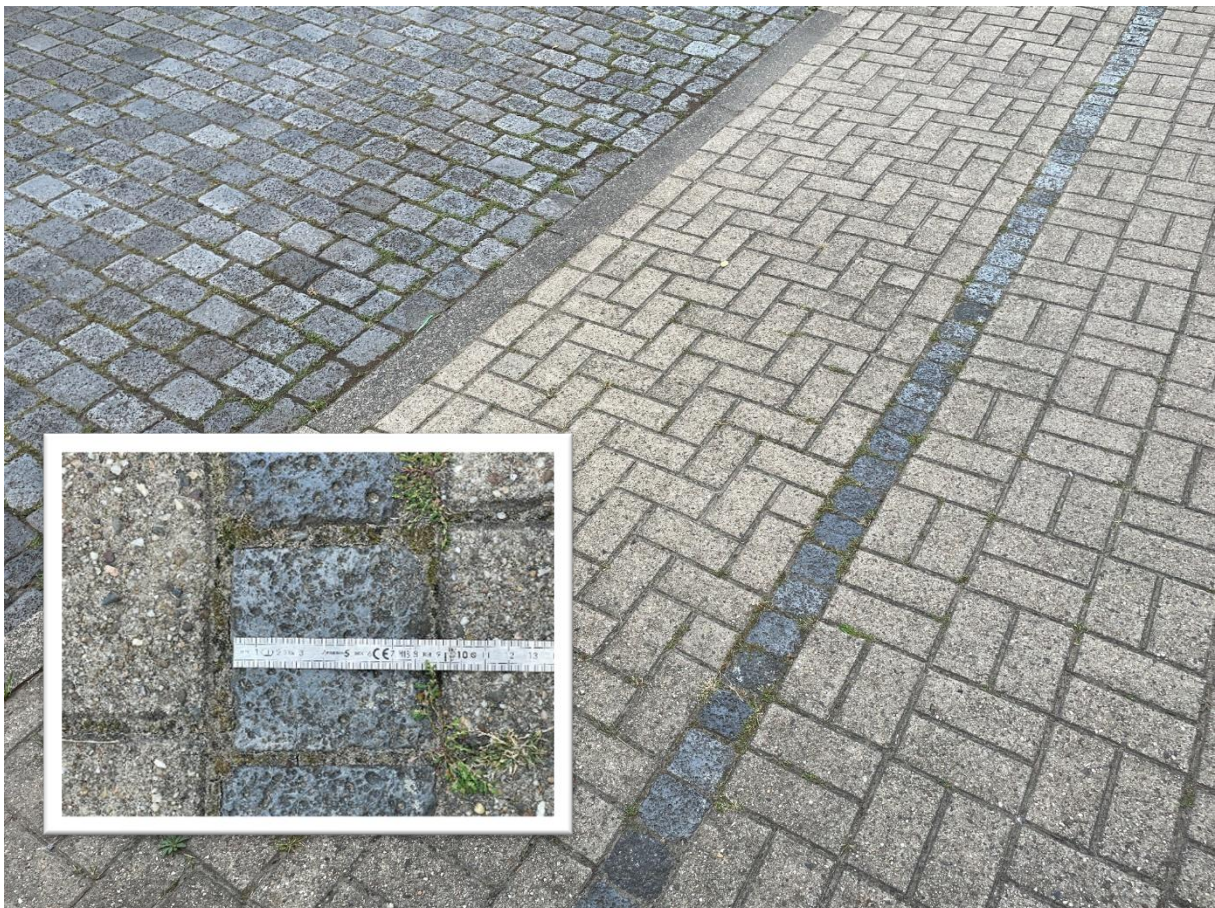
Parkstreifenmarkierung durch Schlackesteine im Format 9 x 9 cm
