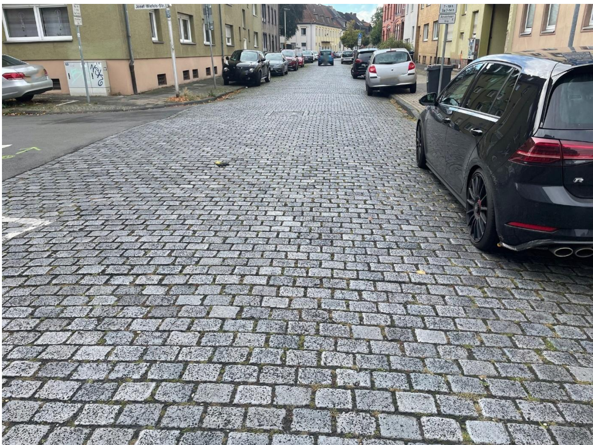
Kentroper Weg in Hamm Richtung Westen an der Kreuzung zur Josef-Wiefels-Straße
